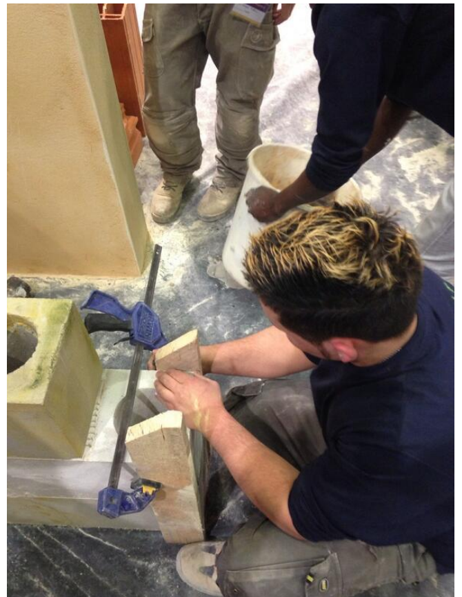
Les apprentis en maçonnerie gros œuvre installent du béton cellulaire
